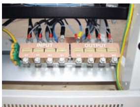
Oberon Y45-15: клеммная колодка для силовых кабелей
